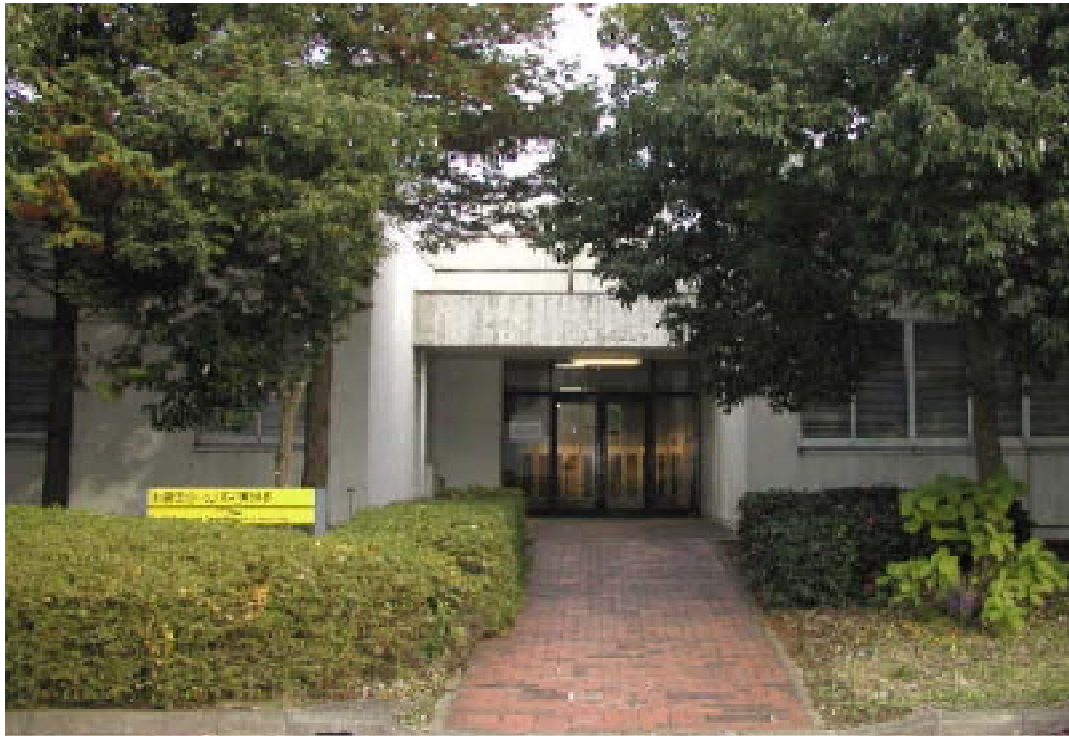
写真-30 土壤モニリス展示室のある土壤保全・モニリス実験棟
